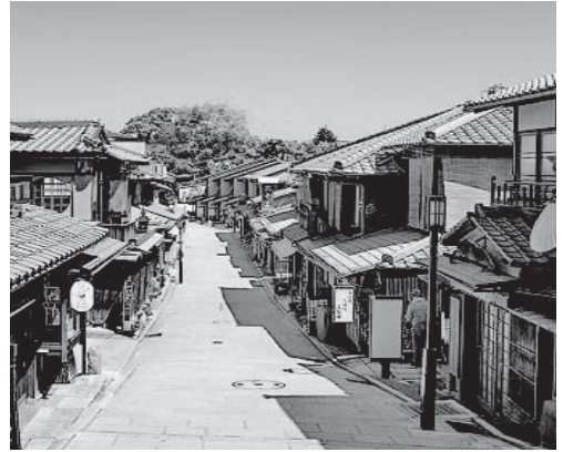
電柱をなくし、電線をすべて地中に埋める
